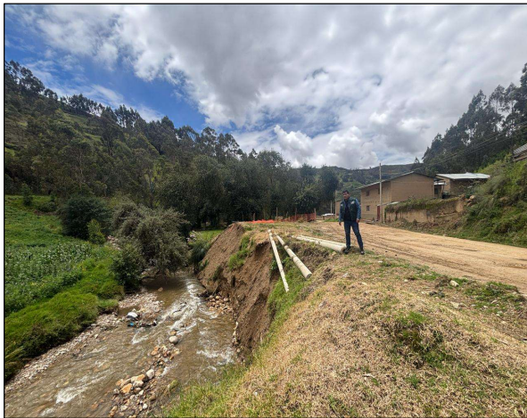
Figura N° 01. Muestra el impacto de la erosión en la margen de una vía cercana al río Porvenir. Se observa un deslizamiento del terreno que amenaza con afectar la infraestructura vial.
