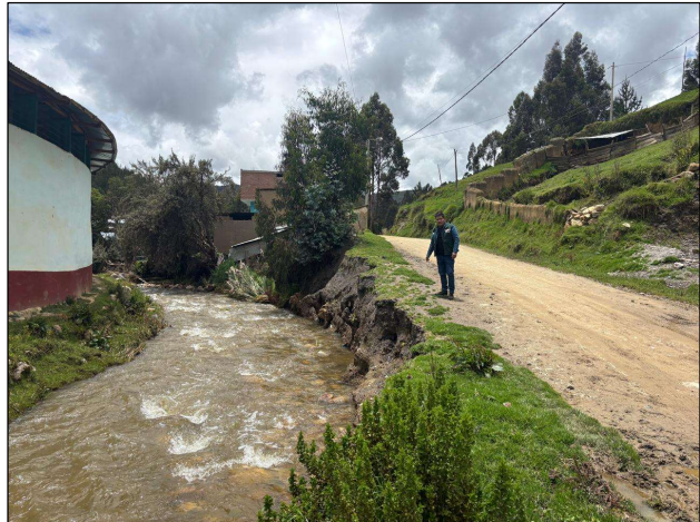
Figura N° 2. Muestra el impacto de la erosión en la ribera del río Porvenir, donde el deslizamiento del terreno ha comprometido la estabilidad de una vía. Se observa en el fondo una vivienda en riesgo por la proximidad del deslizamiento. La erosión progresiva representa una amenaza para la infraestructura y la seguridad de los habitantes de la zona.
